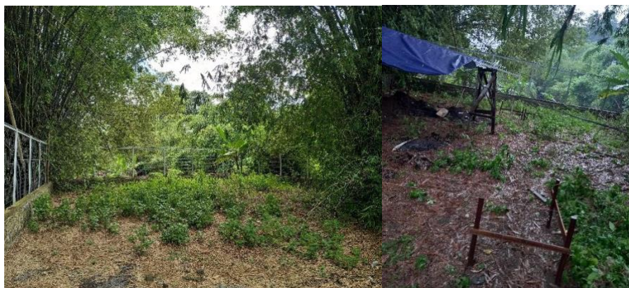
Figure 6: Uitzet Bouwplank Construction
