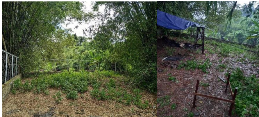
Figure 6: Uitzet Bouwplank Construction
